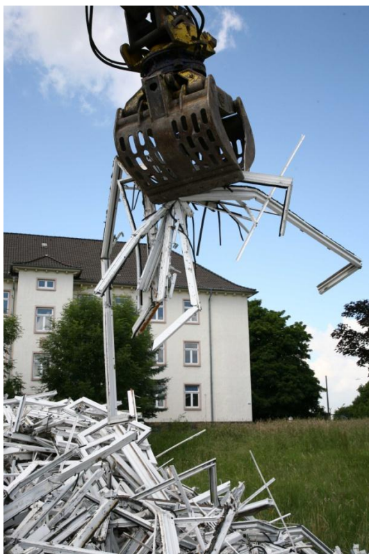
PVC-Fenster auf der Baustelle
